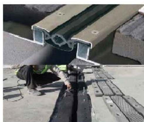
پوشاندن دهانه بالایی درز انقطاع در روی بام ساختمان
