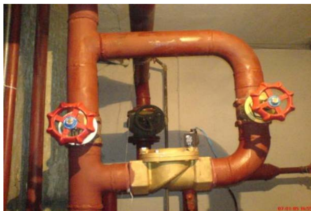
اجرای پروژه شیر برقی
