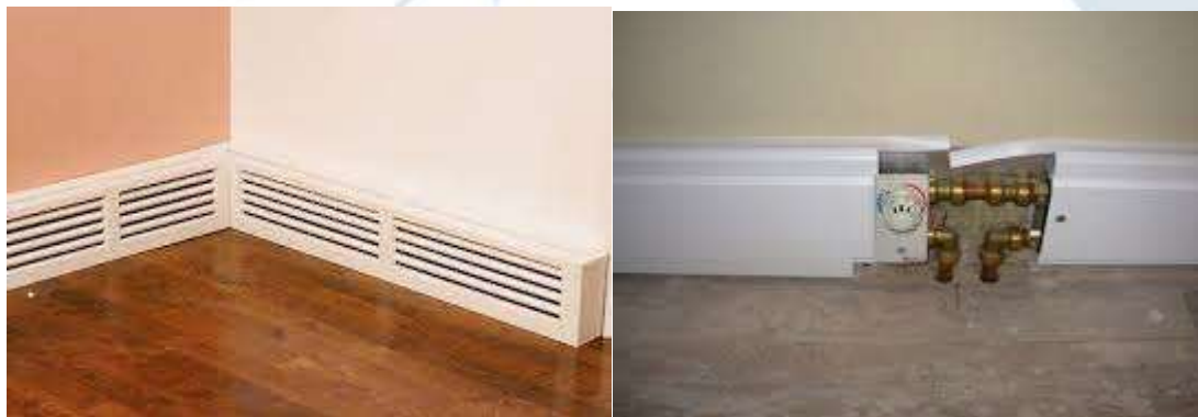
شکل (۲۴) سیستم گرمایشی قرنیزی
