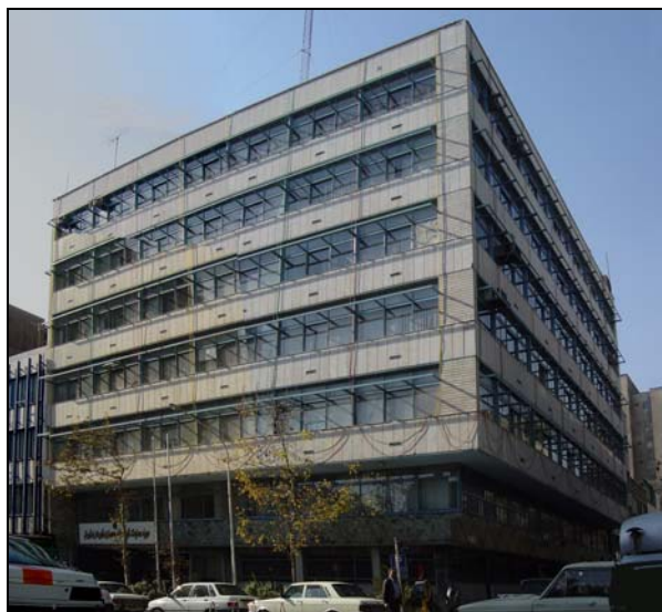
عکس پ ۳-۵۶-۲- نمای شمالی و شرقی ساختمان
