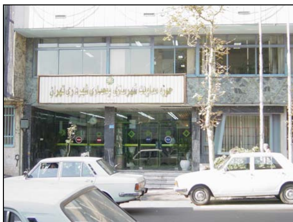
عکس پ ۳-۵۶-۱- ورودی ساختمان در نمای شرقی
