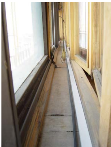
عکس پ ۳-۵۶-۱۵ - پنجره چوبی تعبیه شده در داخل پنجره‌های طبقه ششم
