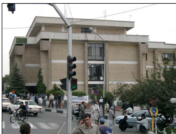
عکس پ ۳-۵۷-۲- نمای غربی ساختمان
