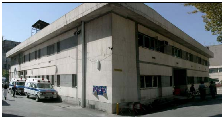
عکس پ ۳-۵۴-۳ - نمای شمالی و شرقی ساختمان ۷-۸
