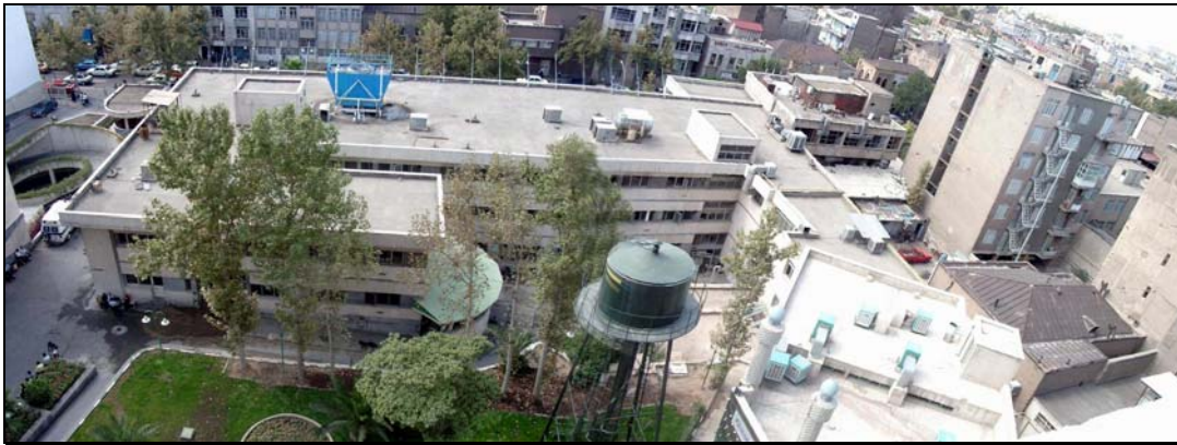
عکس پ ۱-۵۴-۱- نمای شمالی ساختمان ۷ و ۸
