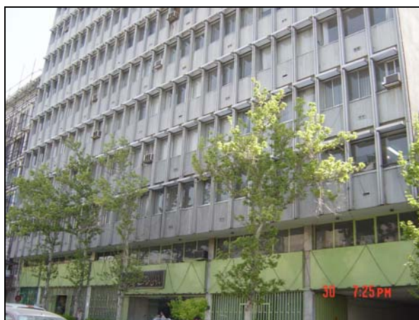
عکس پ ۳-۶۰-۱- نمای غربی ساختمان
