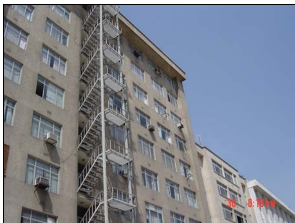
عکس پ ۳-۶۰-۲- نمای شرقی ساختمان
