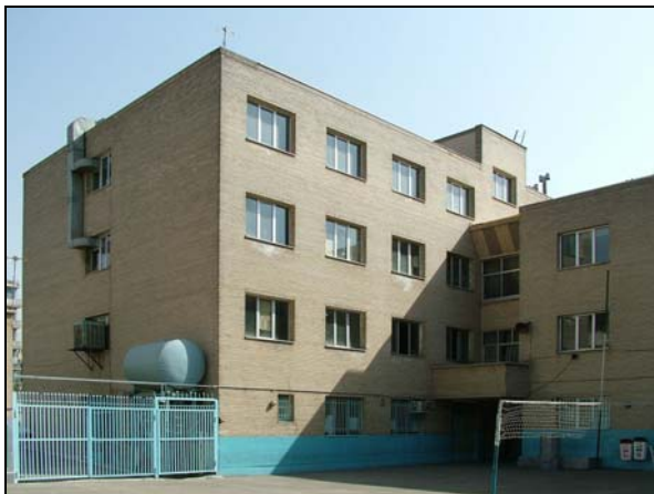
عکس پ ۳-۵۹-۳- حیاط ساختمان و ورودی مسقف آن در محل تقاطع دو یال
