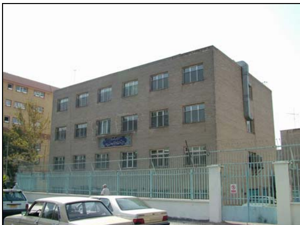
عکس پ ۳-۵۹-۲- نمای شمالی و غربی ساختمان
